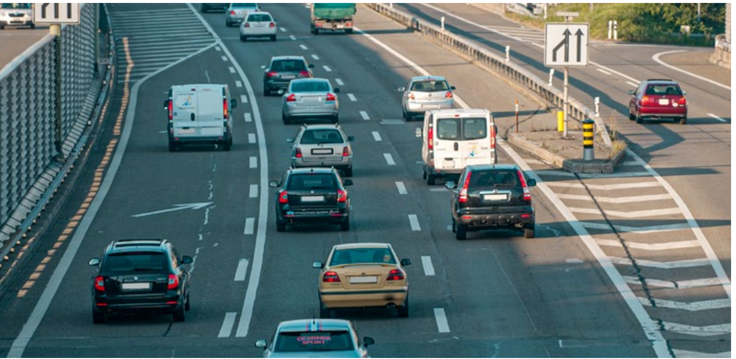
Reissverschluss am Ende der Einfahrt: auf der A1 beim Brüttiseller Kreuz im Raum Zürich.
